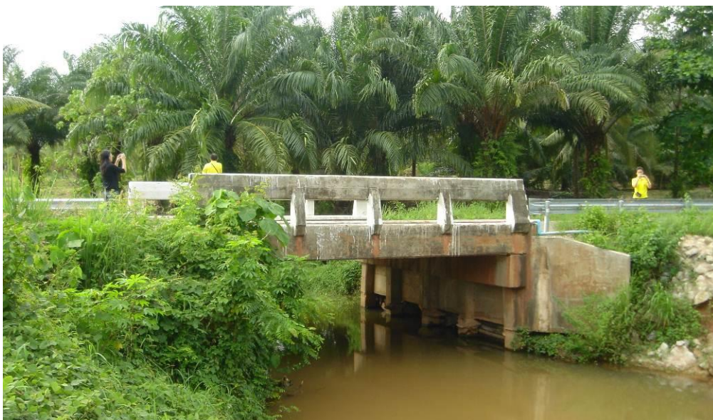
รูปที่ 6-12 สะพานข้ามลำน้ำ
