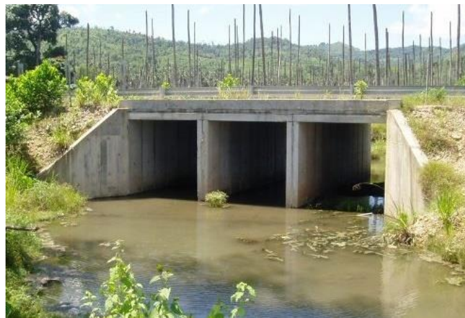
รูปที่ 6-11 ท่อลอดเหลี่ยม
