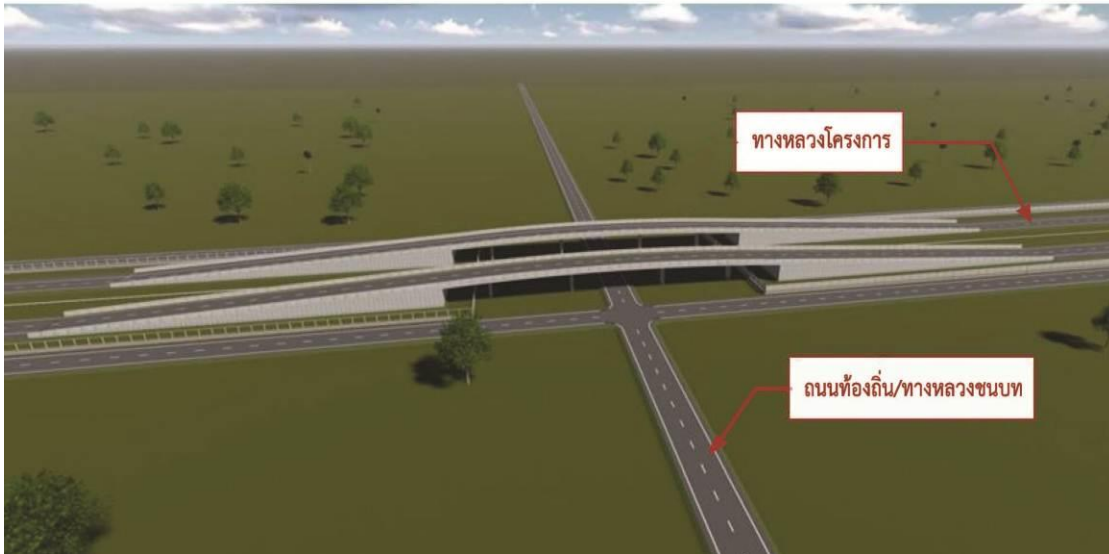
รูปที่ 6-9 ทางลอดที่มีลักษณะเป็นสะพาน
